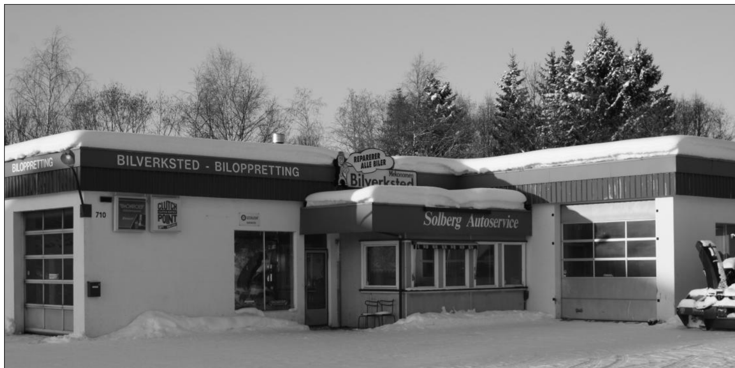
Livsverket til Jørg Solberg. Ikke nok med at han bygde firmaet opp fra bunnen av - han bygde mesteparten av huset selv med sine egne hender også.
